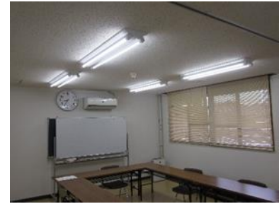
[会議室照明のLED化]
