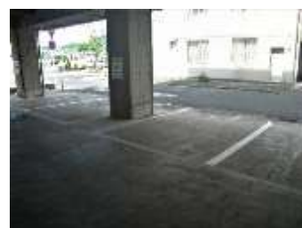
【駐車場枠線の改修】
