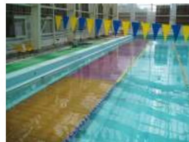
[プールフロアーの設置]
